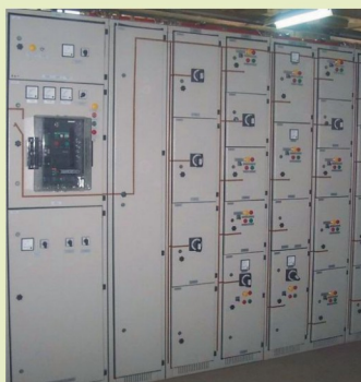
TDRI - constructie compartimentata
